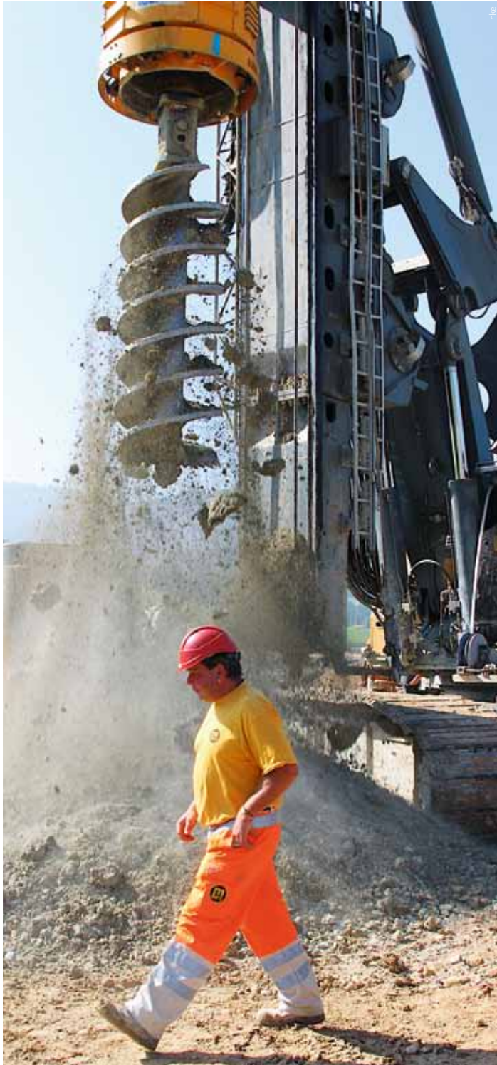
A16 : forage du dernier pieu de la fouille nord du tunnel de Choindex à Courrendlin (JU).
